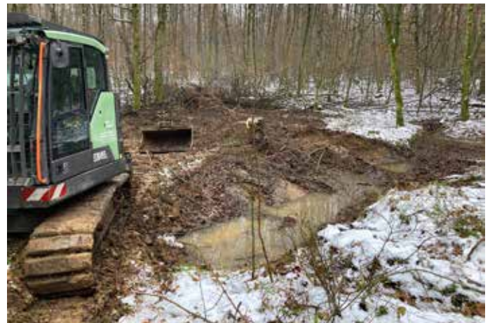
Feuchtbiotop zu Beginn der Sanierung
