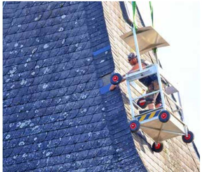
An der Südkante des Kirchturmdaches hatten sich Schindeln gelockert und waren zum Teil bereits zu Boden gefallen: ein Fall von ‚Gefahr im Verzug‘.
