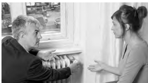
Auf der fünfstufigen Skala eines Heizkörpers mit Thermostatventilen liegen zwischen jeder Stufe etwa vier Grad. Bildnachweis: SSC PLUS
