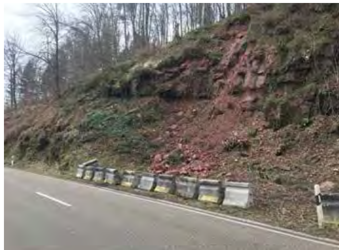
Komplizierter als gedacht entwickelt sich die Baumaßnahme an der bergseitigen Böschung der K 4101. Quelle: Landratsamt Rhein-Neckar-Kreis
