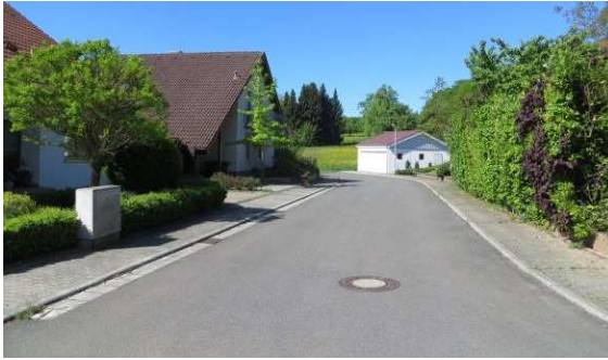
Bild 5: vorhandener Anschluss im best. Wohngebiet
